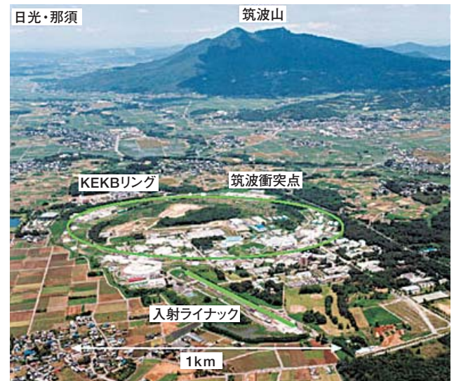
Bファクトリー(KEKB加速器)の全景
