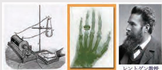
図1 レントゲン教授の実験装置とレントゲン夫人の手のX線写真
