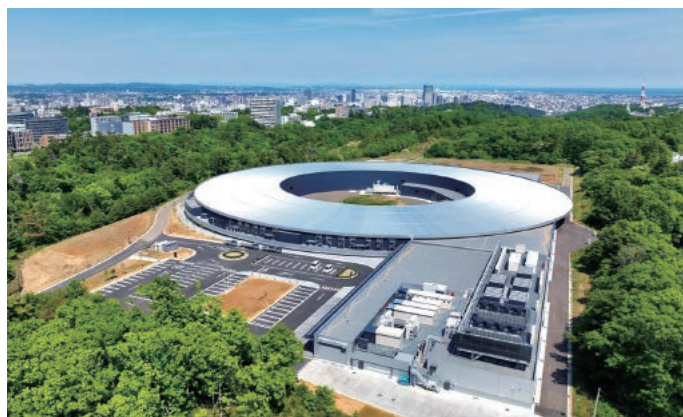
3 GeV高輝度放射光施設 NanoTerasuの全景 奥の円形の建屋が蓄積リング棟、その手前が線型加速器棟
